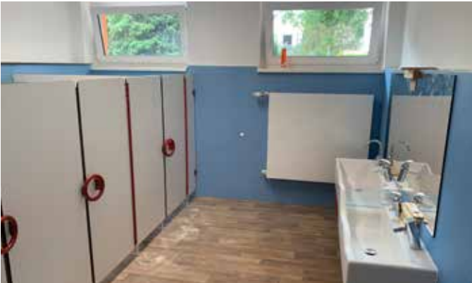
Sanierung der Kita Spatzennest, Sand
